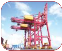
Cầu STS STS Cranes (40T)
