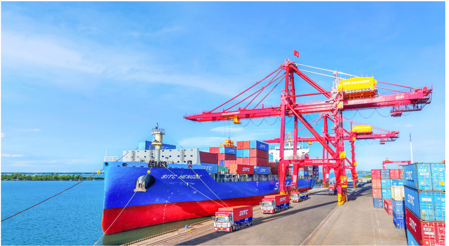
Hệ thống cầu chuyên dụng công suất lớn (STS, RTG), tàu lai dắt, xe đầu kéo công suất lớn
