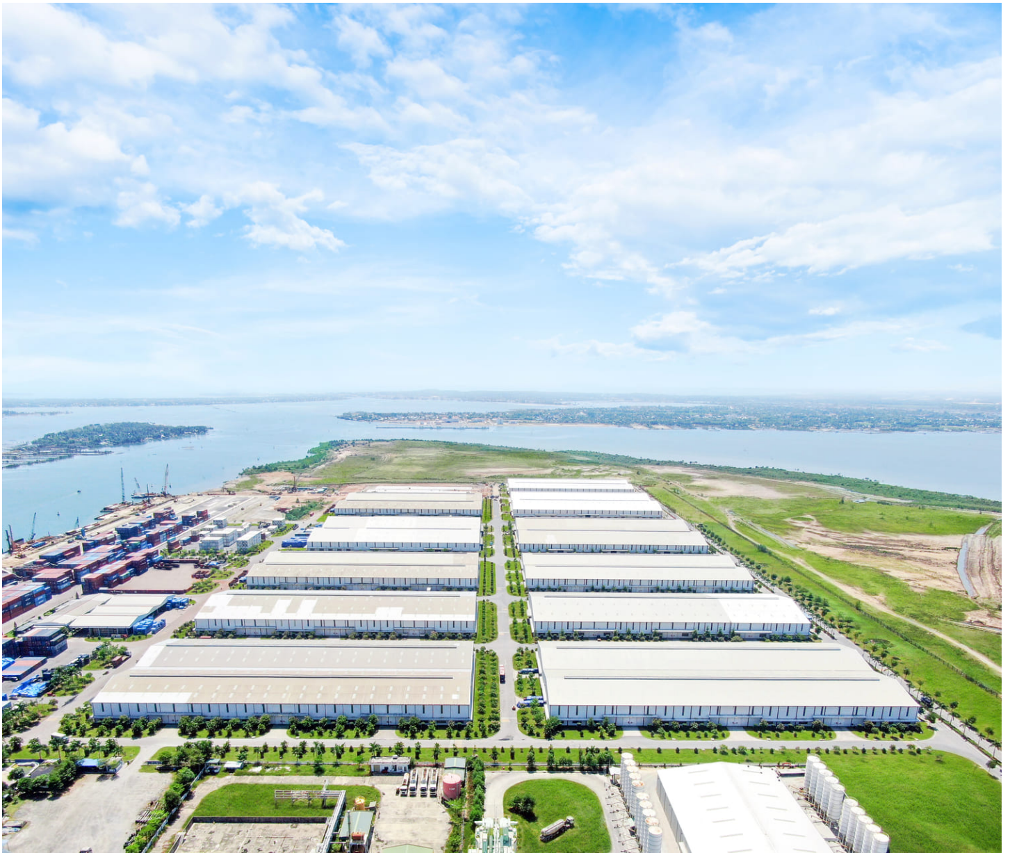
Hệ thống kho, bãi tại cảng Chu Lai
