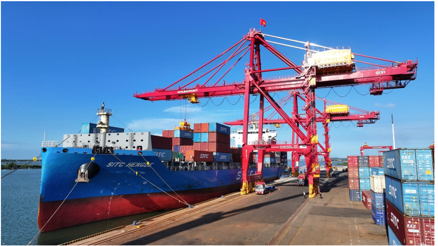
Hệ thống cầu công suất lớn mới nâng cấp tại cảng Chu Lai.
