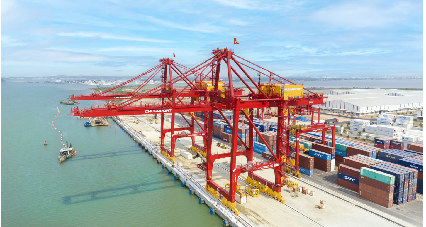
Hình 1: Cầu STS do Tập đoàn THACO INDUSTRIES và DOOSAN VINA phối hợp sản xuất, lắp đặt.
