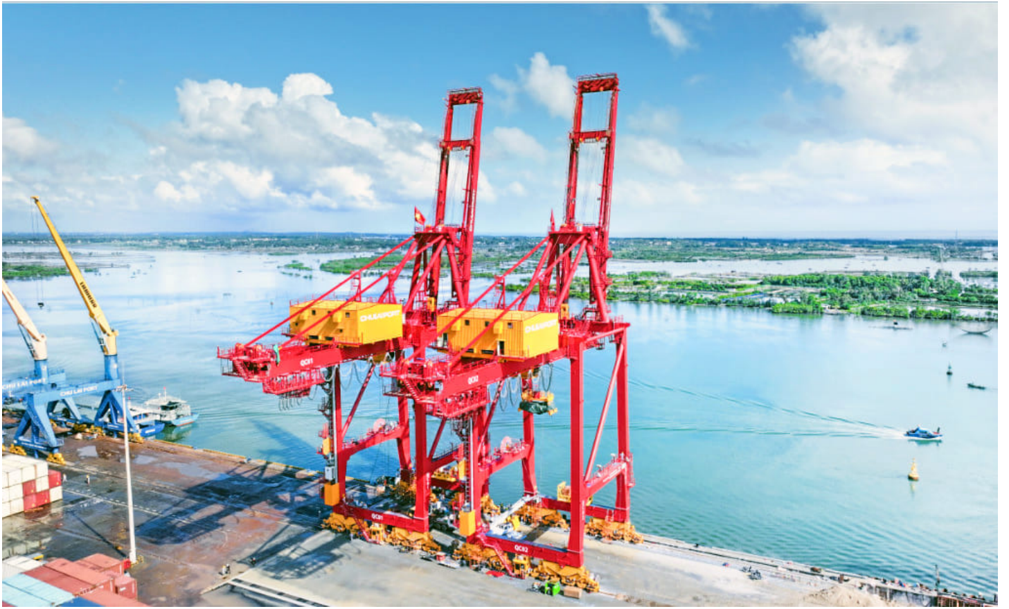
Hình 3: Hai cầu STS sẵn sàng vận hành trên đường ray cầu cảng Chu Lai. Sau thời gian thử nghiệm, hệ thống cầu sẽ chính thức đưa vào hoạt động từ đầu tháng 5/2024.
