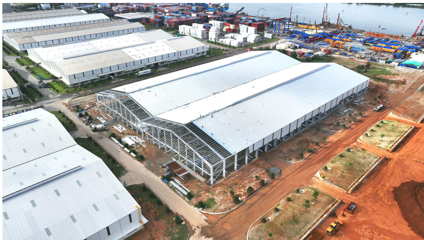
Kho 6, 7 đang thi công
