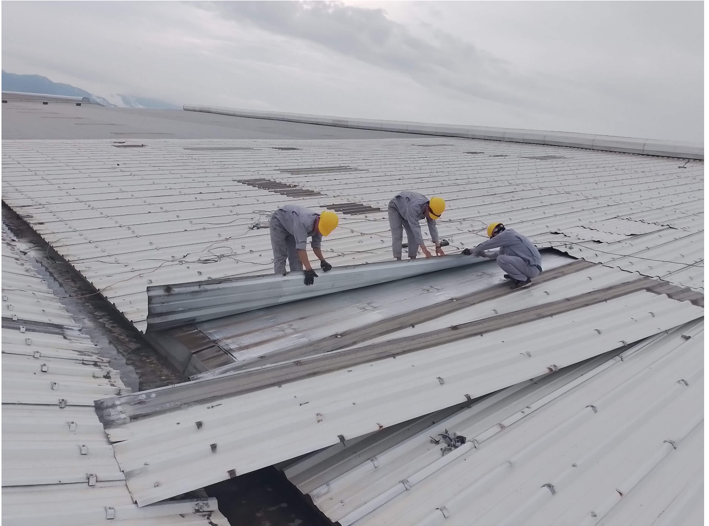
Kiểm tra, gia cố tole mái tại các kho hàng, kho ngoại quan
