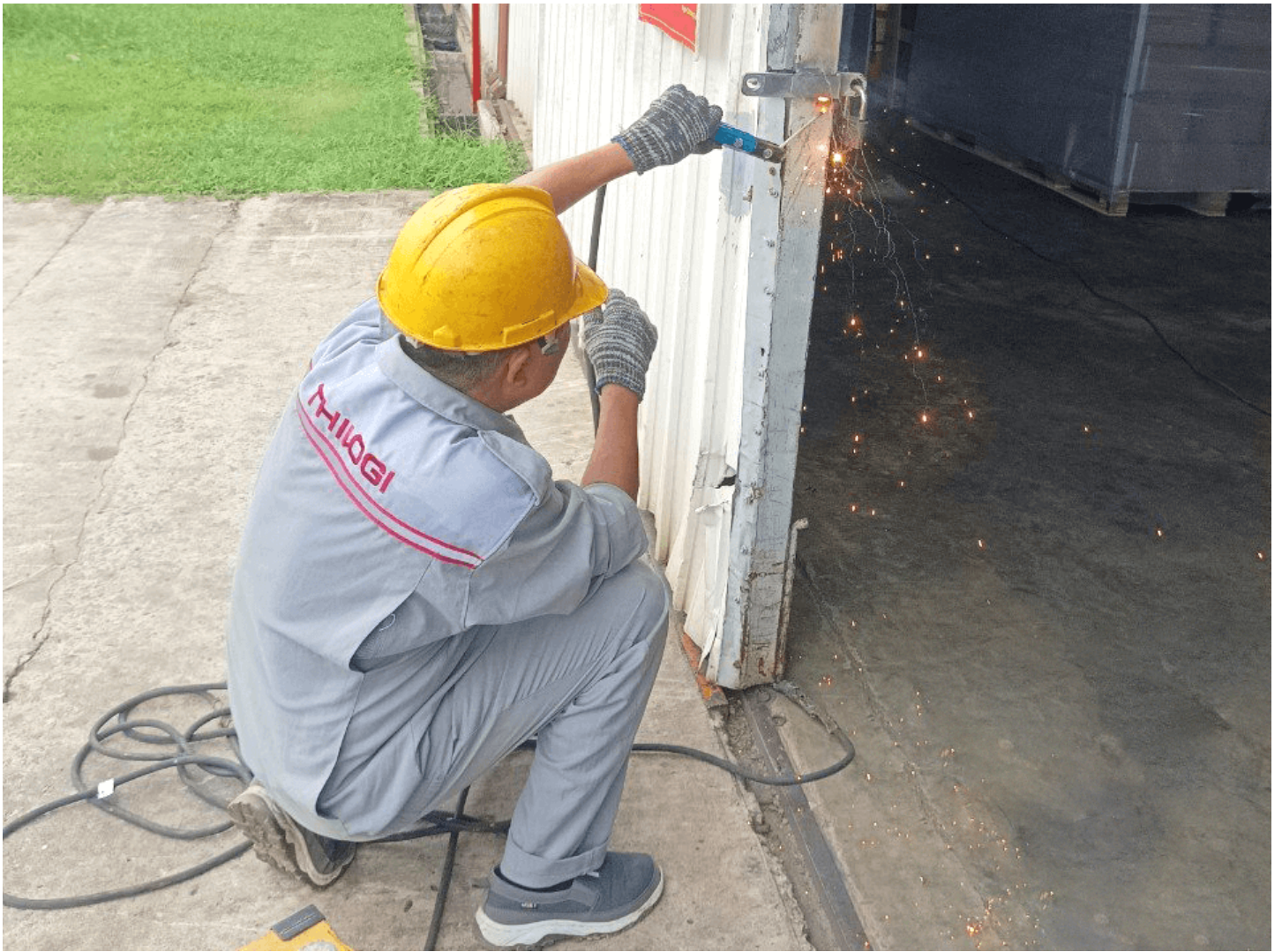
Gia cố cửa chính, cửa sổ tại các kho, xưởng
