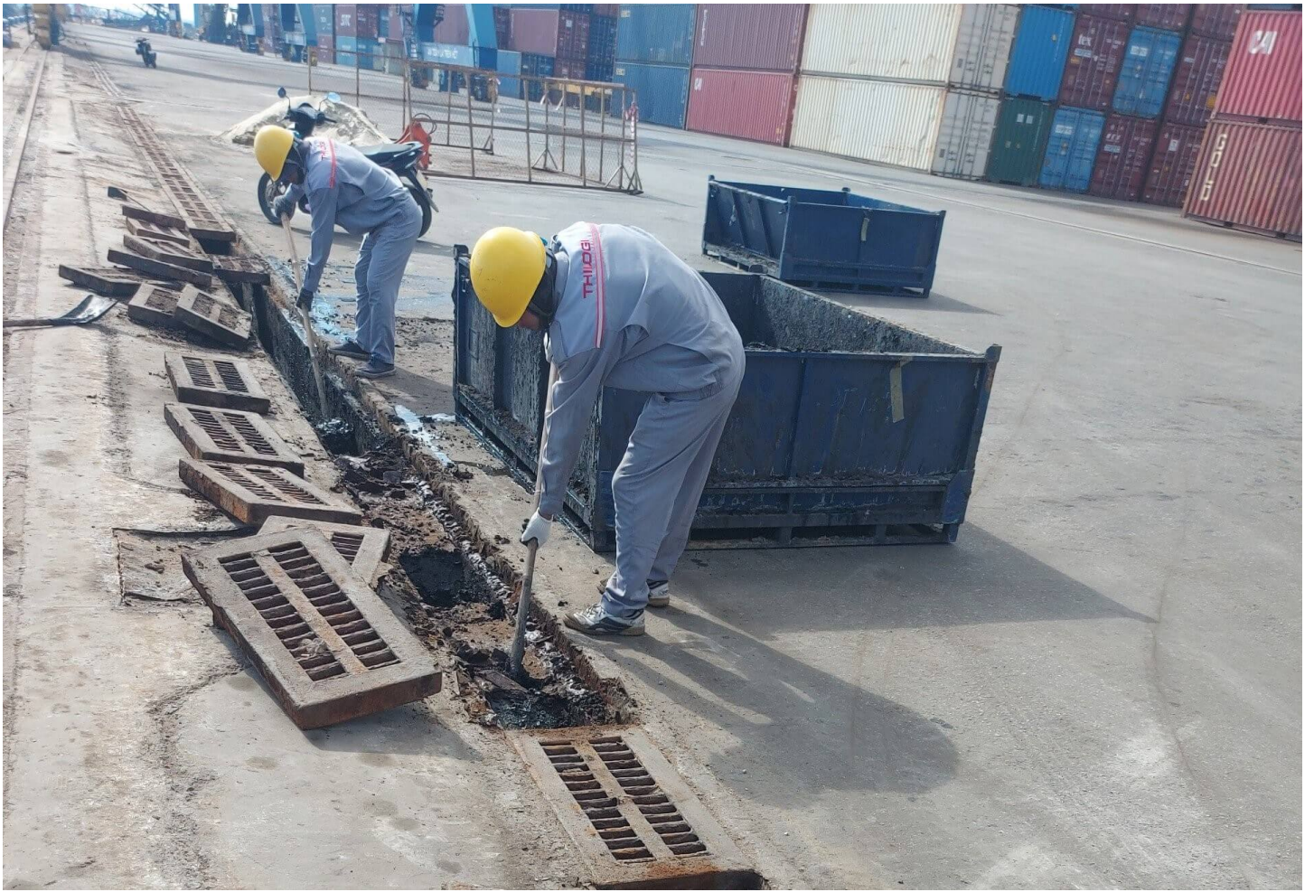
Nạo vét mương, cống, hệ thống thoát nước
