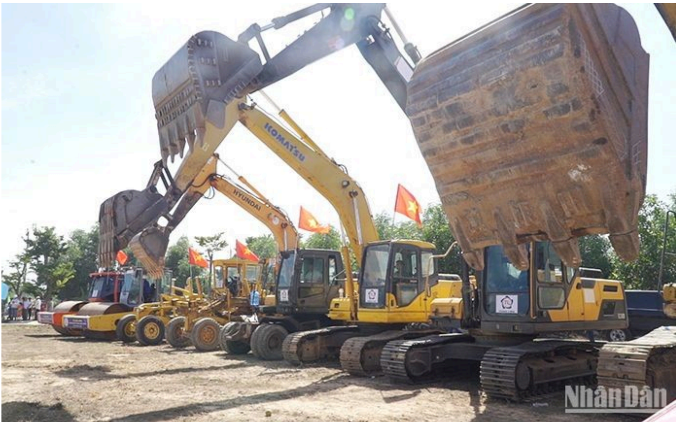
Đơn vị thi công tập trung phương tiện thi công công trình theo đúng tiến độ.
