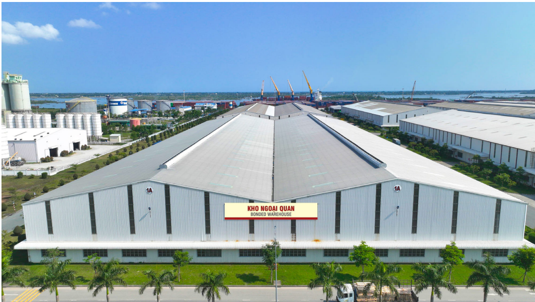
Kho Ngoại Quan có diện tích 13.440m 2 , được xây dựng theo tiêu chuẩn quốc tế tại Cảng Chu Lai
