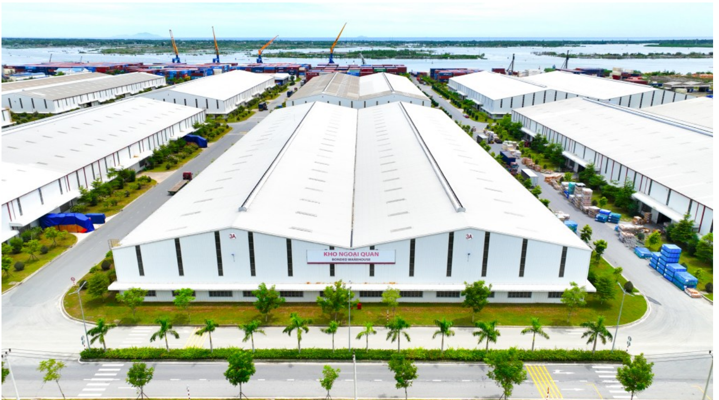
Hệ thống kho bãi tại cảng Chu Lai có diện tích 224.000 m 2 , được phân chia thành các phân khu chuyên biệt như kho ngoại quan, kho hàng, bãi container
